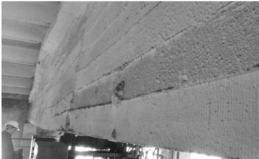
Рис. 1. Балки покрытия пролета Б-В» в осях «2-9» изготовлены в деревянной опалубке и изначально имели прогиб до 70 мм
